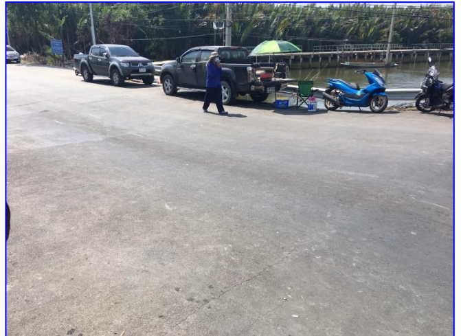
หลังซ่อม
